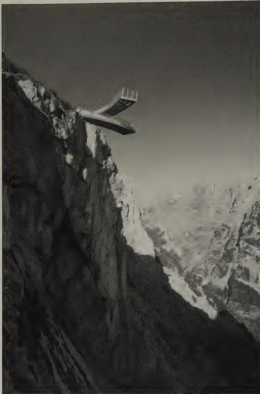
Fig.8 Alpspix viewing platform, Garmisch-Partenkirchen, Germany (Wallmann Architekten, 2010). Credit: Bayerische Zugspitzbahn Bergbahn AG / Benedikt Lechner
