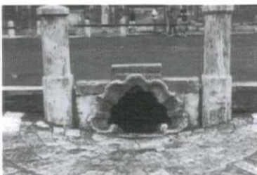
26. Piazza del Palio, central drain.
