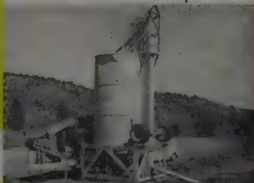
60 min. to set up Silo
