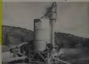
60 min. to set up Silo
