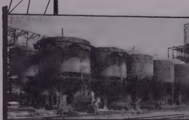
SILOS • HOPPERS • RETORTS
