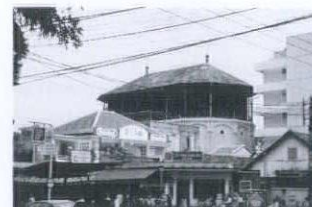
30. 給水塔 Tháp cấp nước 給水塔 Pasteur/不詳/不詳
