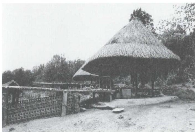
8: 円形の鼠返しが付いた高床の倉。穀物の乾燥がテラスで繰り返される。
