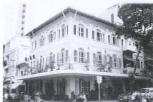
5. ベトナムハウス Việt Nam house 事務所 93-95 Đồng Khởi/不詳/不詳
