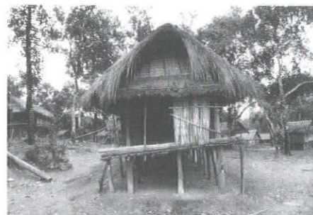
17: ハレー族の住まいは傾斜地に配置され、下手の床を少し高くすることに特徴がある。
