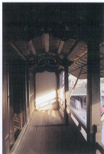
総2階タイプの建物のベランダ。天井は黄桷天井
