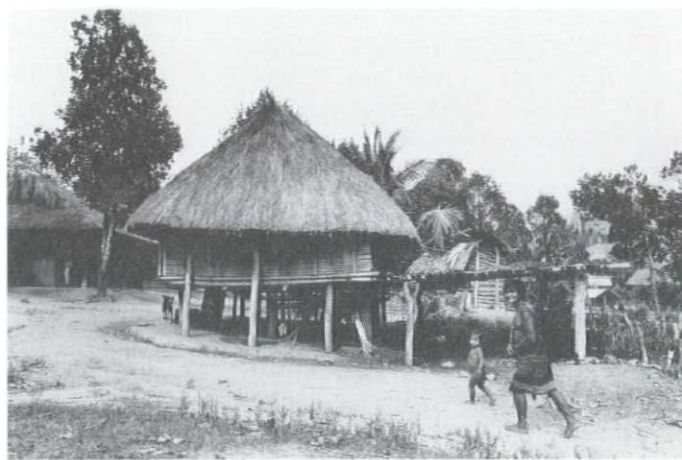
9: ドンと呼ばれるカトゥー族の杭上式民家。両脇に棟持柱が立つ。住まいに接してテラスが接続され、穀物の乾燥がおこなわれる。
