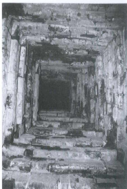
迫り出し構造で造られた屋蓋の見上げ、ミソンC3
