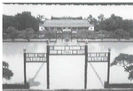
台風により浸水した王宮
