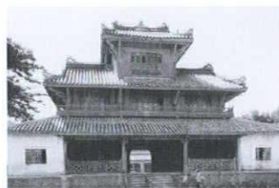
19. 顯臨閣 Hiển Lâm Các 131 Nam Kỳ Khởi Nghĩa/1884年 明命年間初期 世廟の南に建つ三層の樓閣。中央の4本の柱は約12mで、三層を貫いている。この北側に九鼎が並ぶ。左右の門は三間二層の樓門であり、それぞれの楼に鐘、太鼓を持つ。
