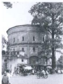
90. 給水塔 Tháp nước 給水塔 Phan Đình Phùng/不詳/不詳
