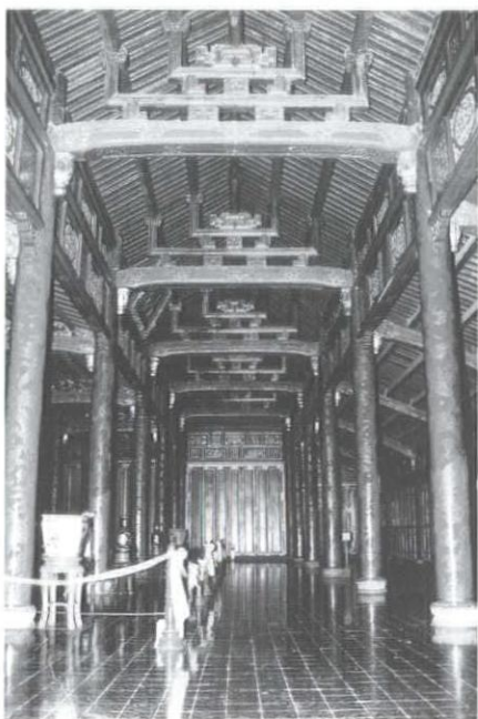
9: 太和殿内の鉤手状の架構体
