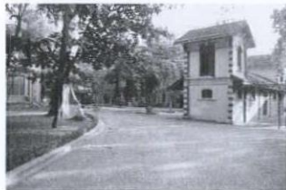
74. ホーチミン廟内倉庫 Khu di tích của Bác Hồ 植物園内倉庫 Hùng Vương/不詳/不詳
