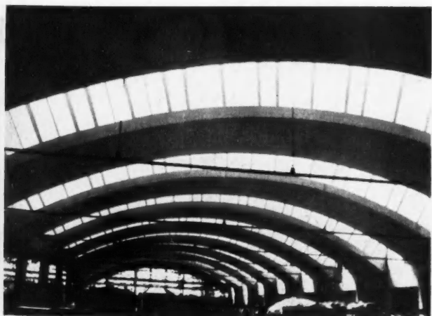
CI-CONTRE : Aspects des sheds coniques vus sous différents angles une fois terminés, et, en cours de construction, avec l'échafaudage de soutien.
