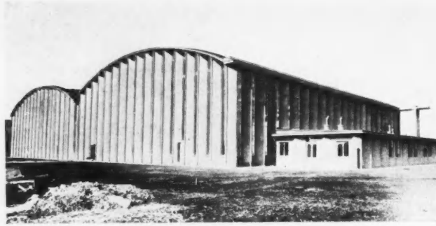
1. Hangars de 60 mètres de portée construits à Pancevo (Yougoslavie) en 1936-1937.
