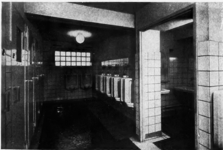
VUE DES ARMOIRES-VESTIAIRES. Remarquer la plinthe à gorge en retrait formant socle.
