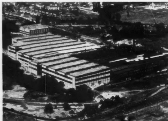
USINOR groupe B. Laminiers de MONTATAIRE. Sous-toiture avec chape. Surface : 45.000 m 2 . USINOR groupe A, même réalisation. DENAIN : 90.000 m 2 .
