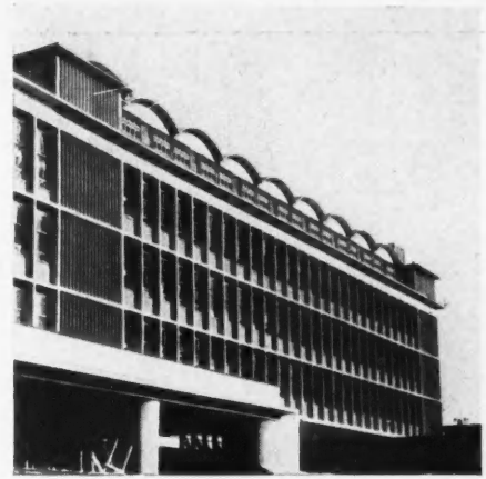
VUE DE LA FAÇADE.
