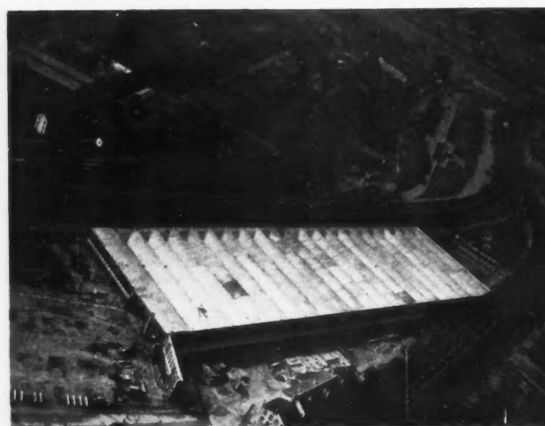
4. Halle à marchandises de Lyon-Guillotière. Halle Nord (surface 25.000 m 2 ). P. Peirani, Architecte.
