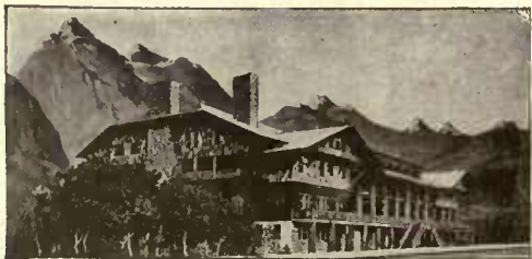
S. L. Bartlett, architect, St. Paul.
