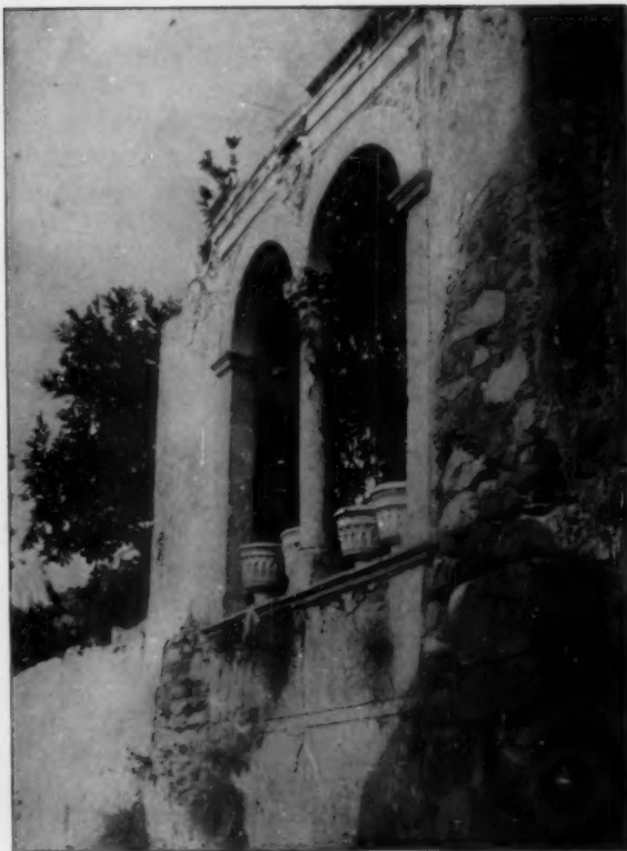
A WINDOW OF THE CASA CIAMPOLI
