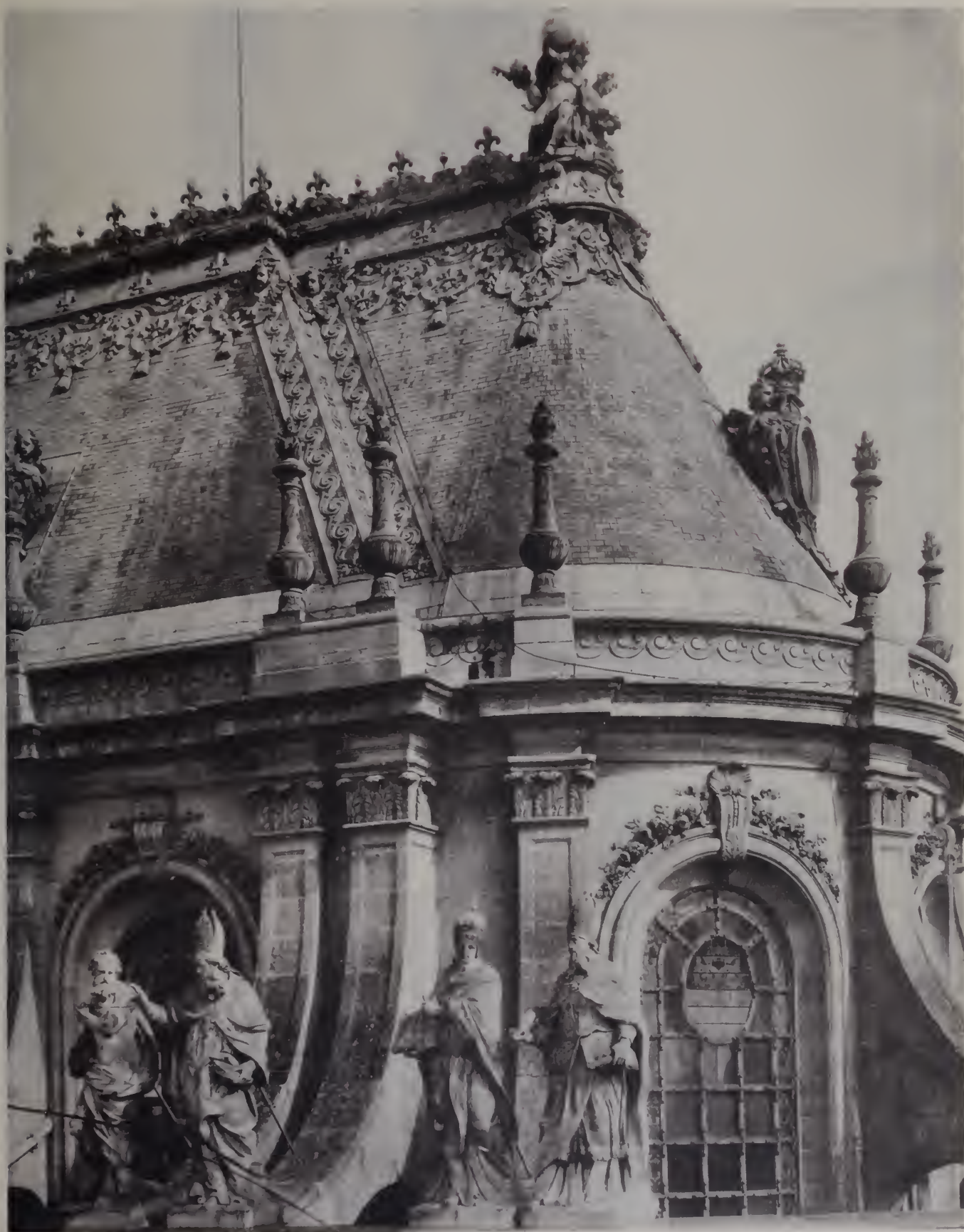
VERSAILLES DETAIL OF FACADE DE LA CHAPELLE
