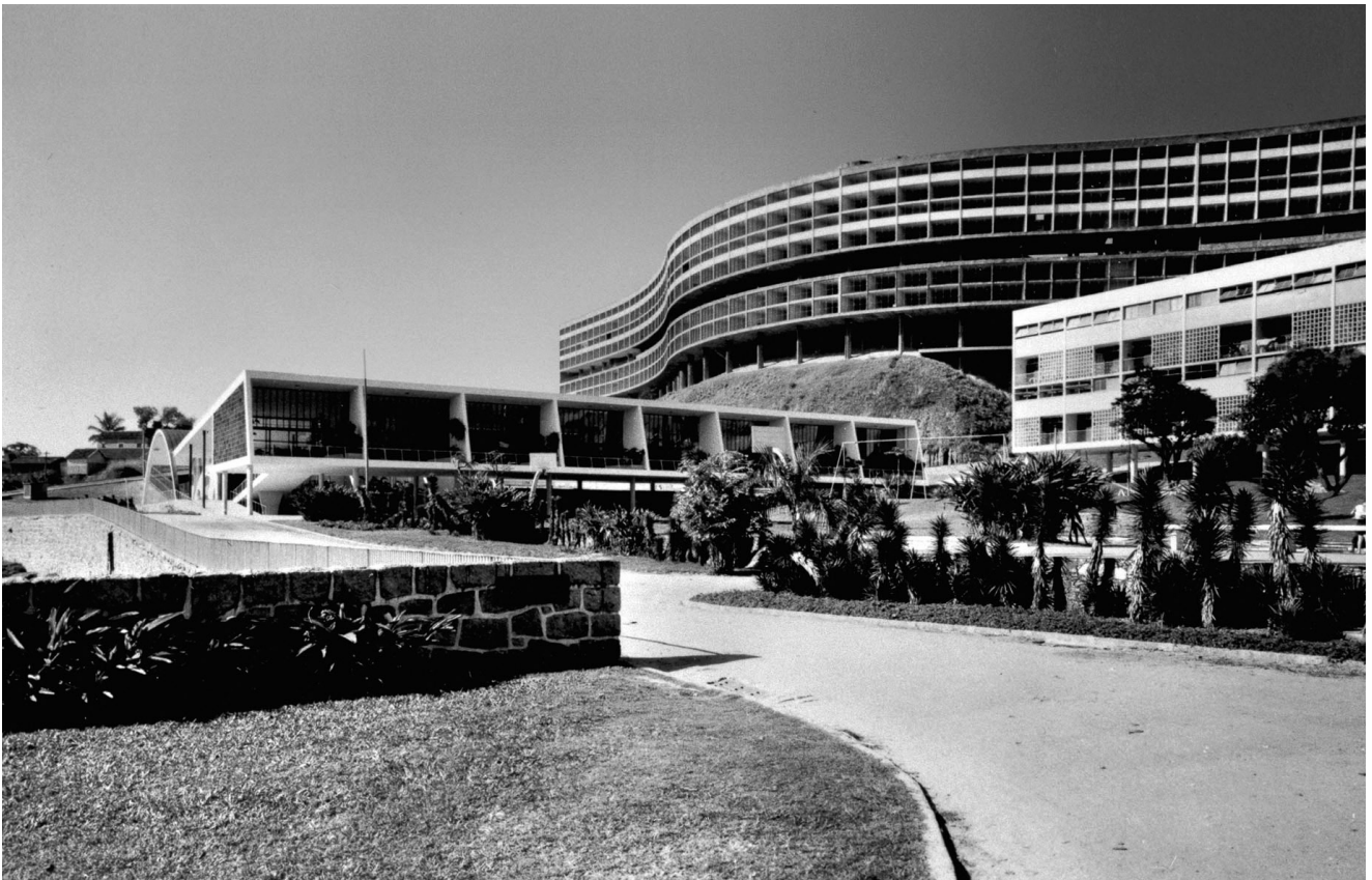
02 Alfonso E. Reidy, Carmen Portinho, Pedregulho Housing Complex, Rio de Janeiro, Brazil, 1948-1960. © Grupo de Pesquisa Pioneiros da Habitação Social no Brasil, c. 1950.
