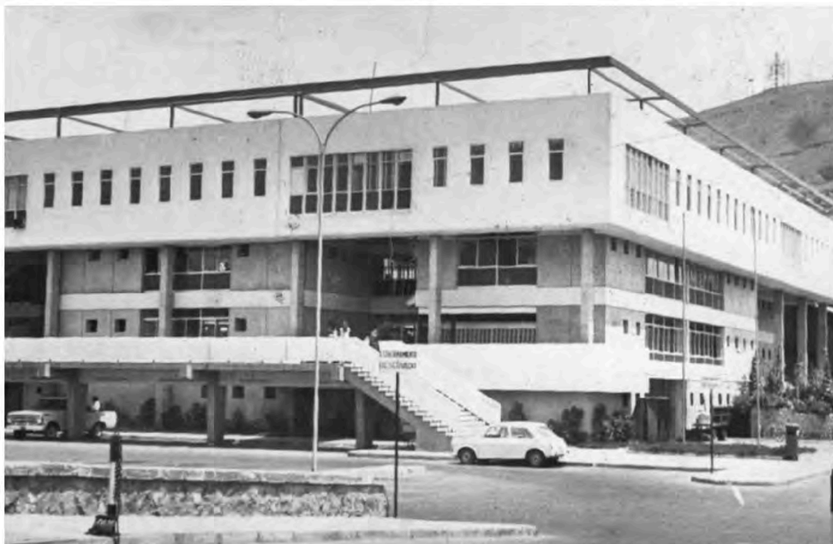
Figure 2: Public Services Bldg. Direction of Architecture. Ministry of Publics Works. 1966. Arica. Archivo Histórico Vicente Dagnino, Universidad de Tarapacá.
