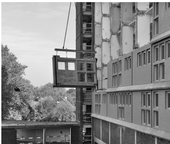
03 Willy Van Der Meeren, Ieder Zijn Huis , Brussels, Belgium, 1953–1961. Recomposition of the façade with the new prefabricated sandwich panels. © ORIGIN, Georges De Kinder.
