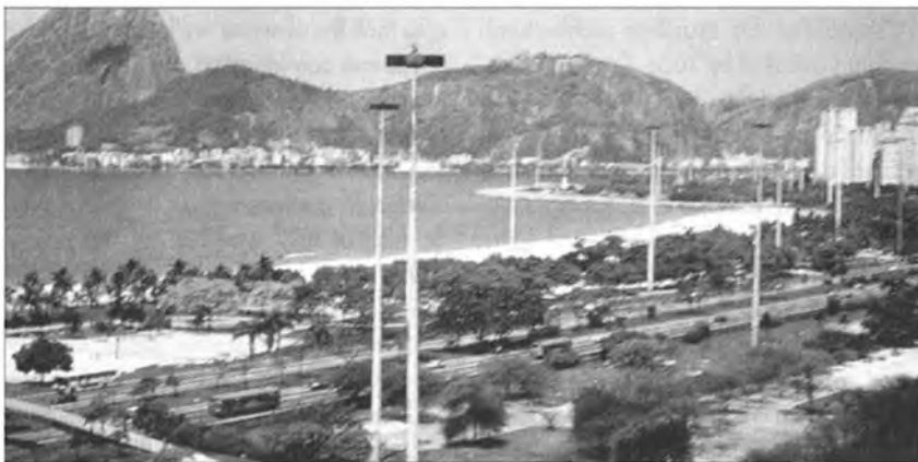
Flamengo Park. Rio de Janeiro, Brazil, 1961.
