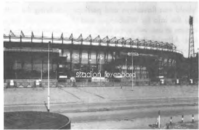
Rotterdam, Feyenoord Stadium (J.A. Brinkman en L.C. van der Vlugt, 1936-37), general view outside (situation 1983).
