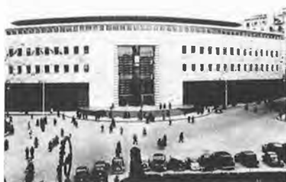
G. Pagano, Palazzo delle Poste in Napoli, 1928-36.
