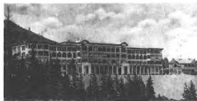
Sanatorium Schatzalp 1899-1900, Pflegehard und Haefeli. Dieses Sanatorium war die erste Privatheilstätte in Davos, die ihre Patienten nach der Turbanschen Therapie behandelte. Der Bau war das erste Stahlbetongebäude der Region.
