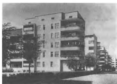
Bebauung südlich der Magistrale.
