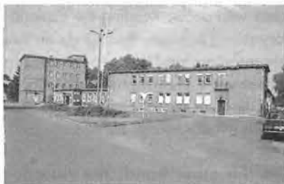
Kopfbauten mit Direktionsgebäude (links), Verbindungstrakt und Vorbau, errichtet Anfang der 50er Jahre. Heutige Situation.
