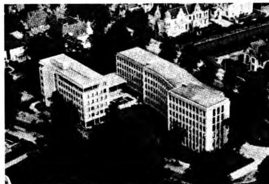
Fig. 9 – Air view of the National Versicherungs-Gesellschaften headquarter, on Travemünder Allee, Lübeck. Source: Verkehrsamt der Hansestadt Lübeck, 1967-68.
