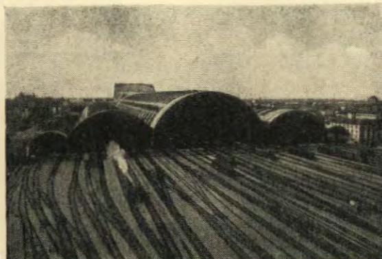
31 Milan, Stazione Centrale, 1920-31, Ulisse Stacchini, five spans, widest 236 ft.
