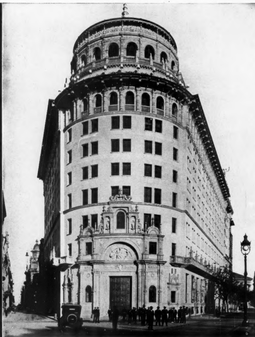
Banco de Boston, Buenos Aires. Architects: Chamber & Thomas.
