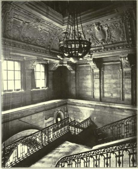
CEILING, CORNICES, TRUSSES, &c., IN FRENCH STUC.
