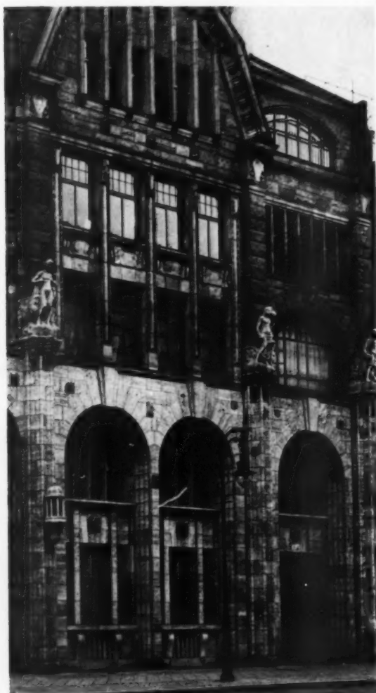
REMODELLED BUILDING FOR DEUTSCH SÜDAMERIKANISCHE BANK, BERLIN
