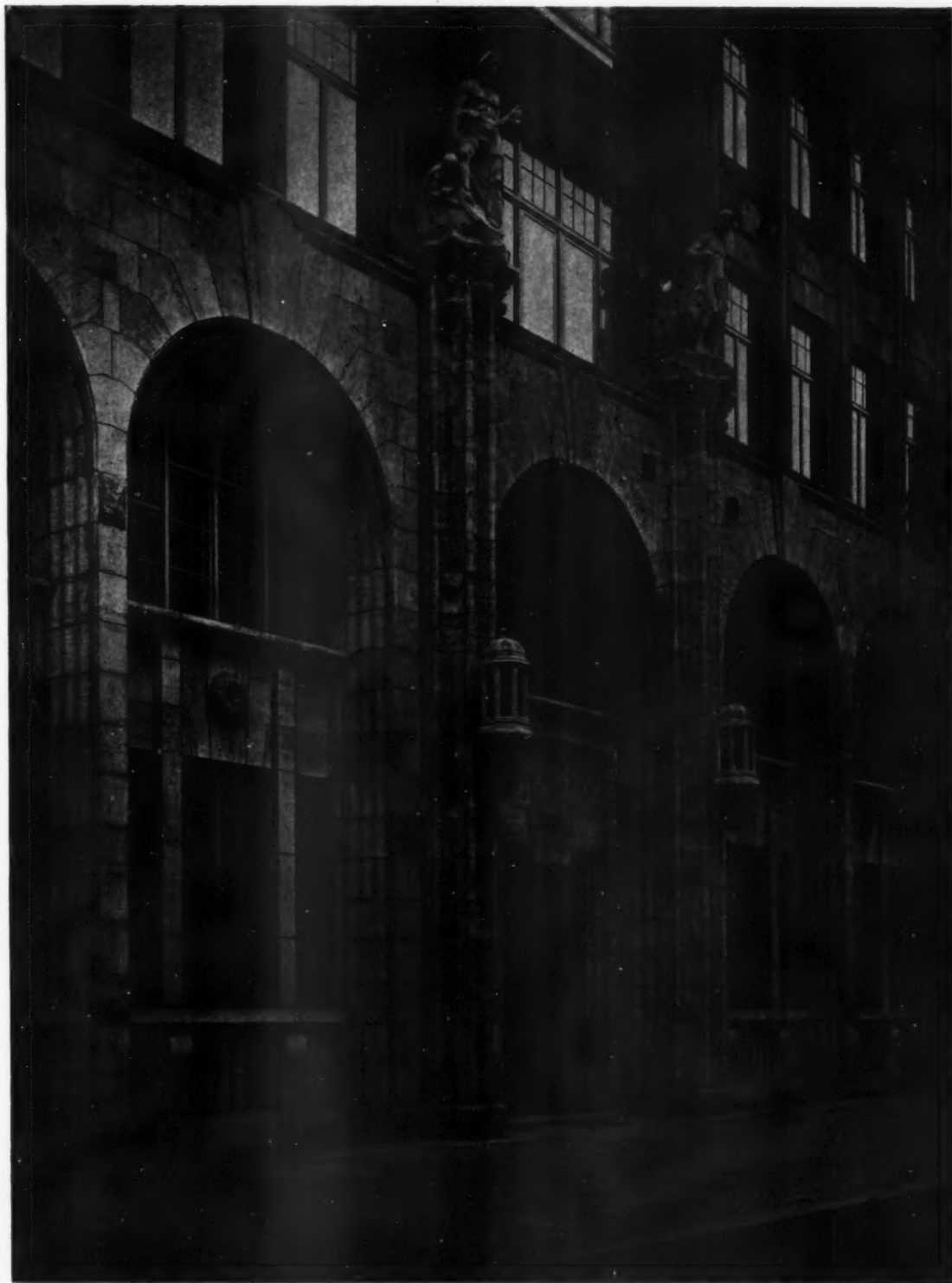
REMODELLED BUILDING FOR DEUTSCH SÜDAMERIKANISCHE BANK, BERLIN MR. SCHUETTE, ARCHITECT
