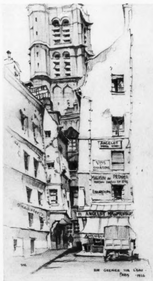
RUE GRENIER SUR L'EAU, PARIS
