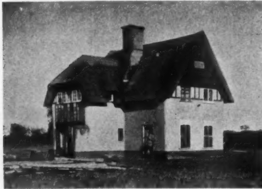
PISÉ DE TERRE HOUSE AT NORTH WALSHAM, ENGLAND
