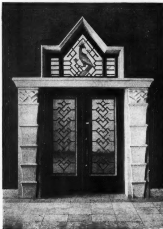
REGIERUNGSBAUMEISTER BODE, ESSEN
