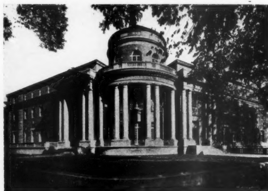
Y. M. C. A. BUILDING, GREENWICH, CONN. M. L. & H. G. EMERY, ARCHITECTS
