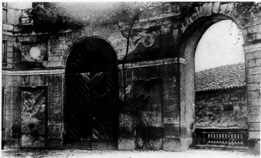
COURTYARD, PALAZZO MEDOLAZO, BERGAMO
