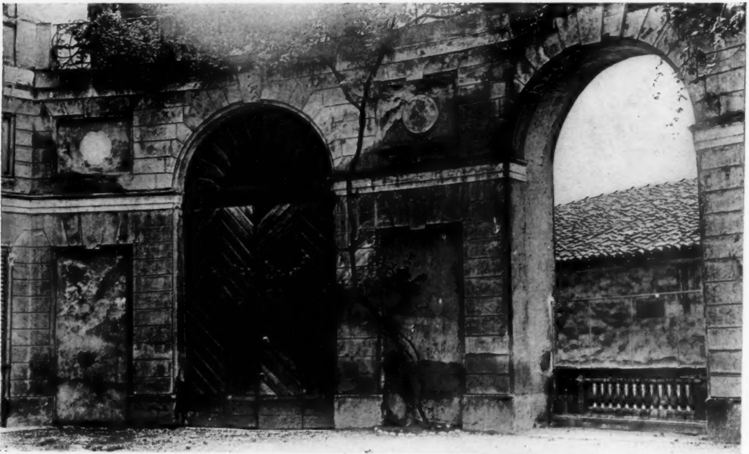
COURTYARD, PALAZZO MEDOLAZO, BERGAMO
