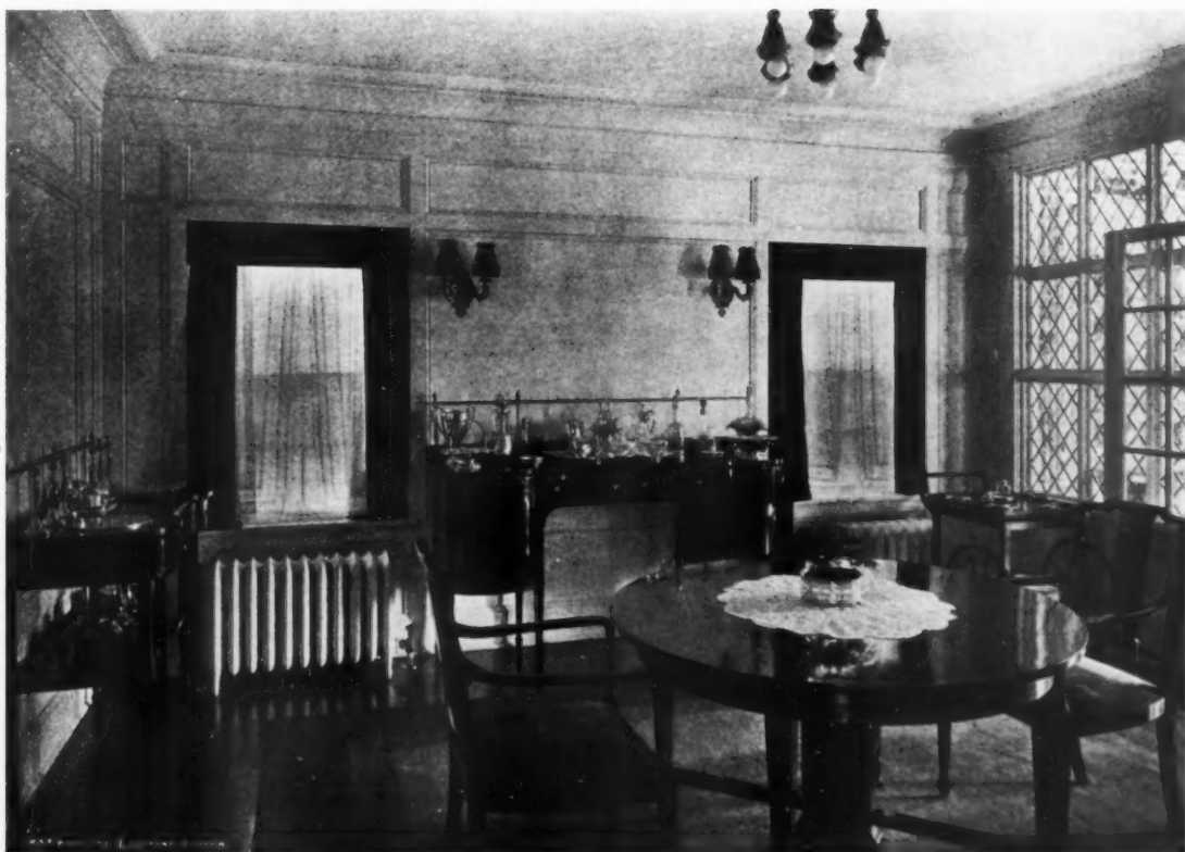
HOUSE OF A. H. BOSWORTH, ESQ., DENVER, COLO.
