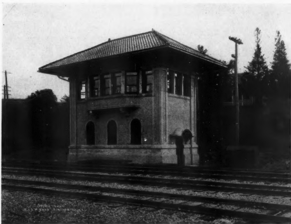
SWITCH TOWER ON D. L. & W. R. R., BINGHAMTON, N. Y. MR. F. J. NIES, ARCHITECT
