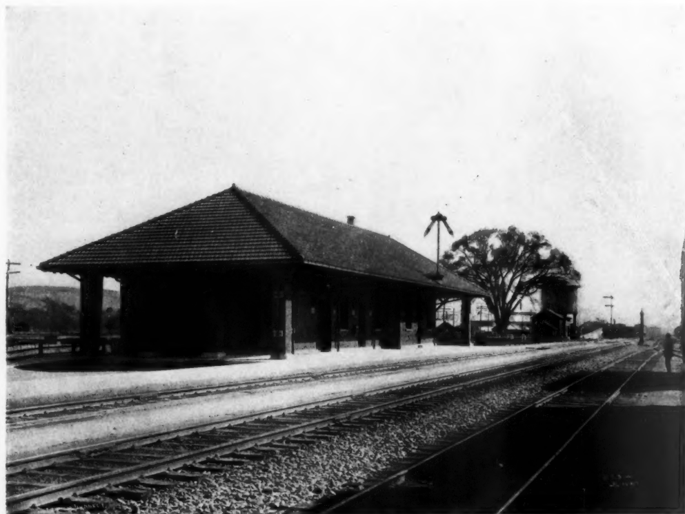
BATH STATION, D., L. & W. R. R., MR. F. J. NIES, ARCHITECT
