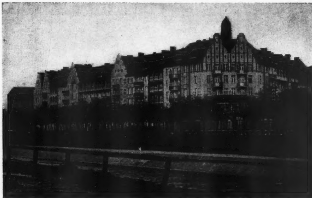
GENERAL VIEW BERLINER SPAR UND BAUVEREIN
