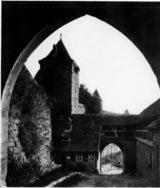
THE KABALZELLER GATE
