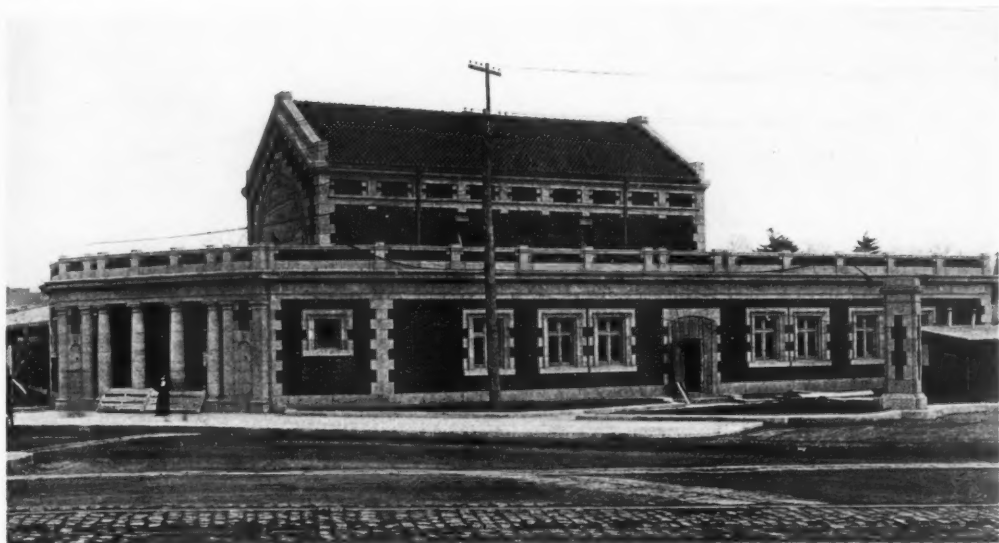
MONTCLAIR, N. J., STATION, D. L. & W. R. R. ENGINEERING DEPT., D. L. & W. R. R., ARCHITECTS
