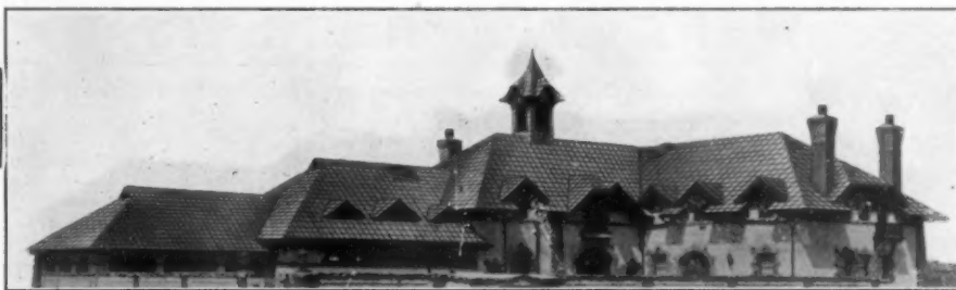
Asbestos "Century" Shingle Roof—Estate of T. M. Davis, Newport, R. I.
