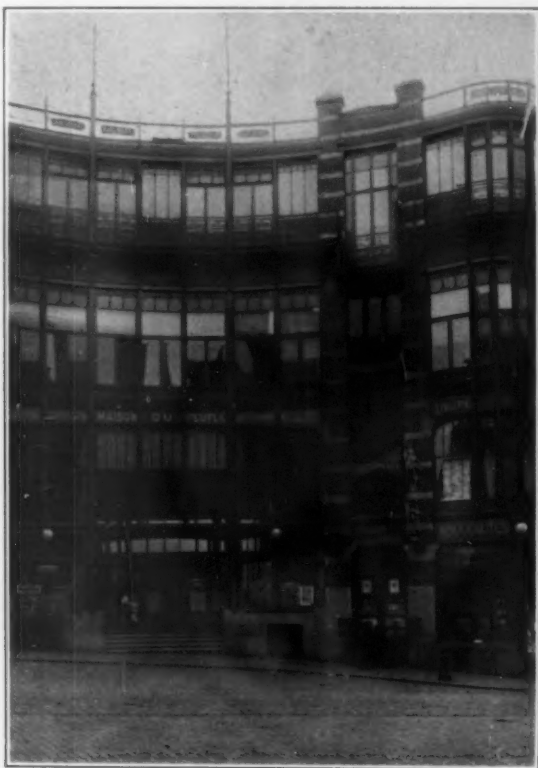
MAISON DU PEUPLE, BRUSSELS. HORTA, ARCHITECT.
