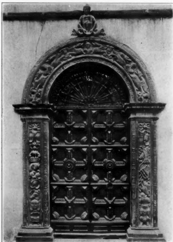
DOORWAY: PALAZZO ORSETTI, LUCCA.
