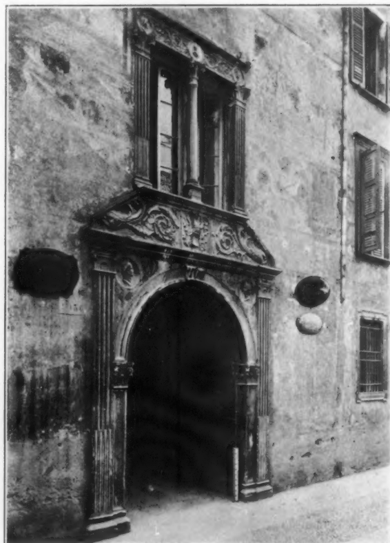
DOORWAY: PALAZZO CALZAVEGLIO, BRESCIA.
