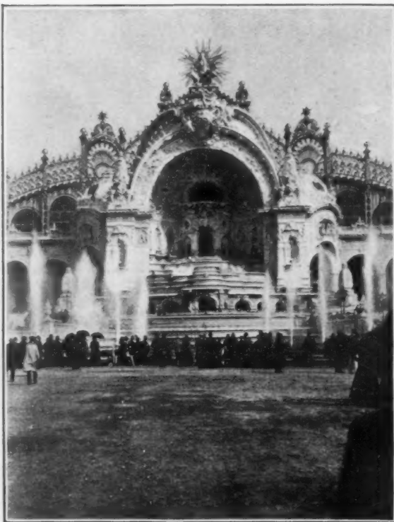
Chateau d'Eau. M. Paulin, Architect.
