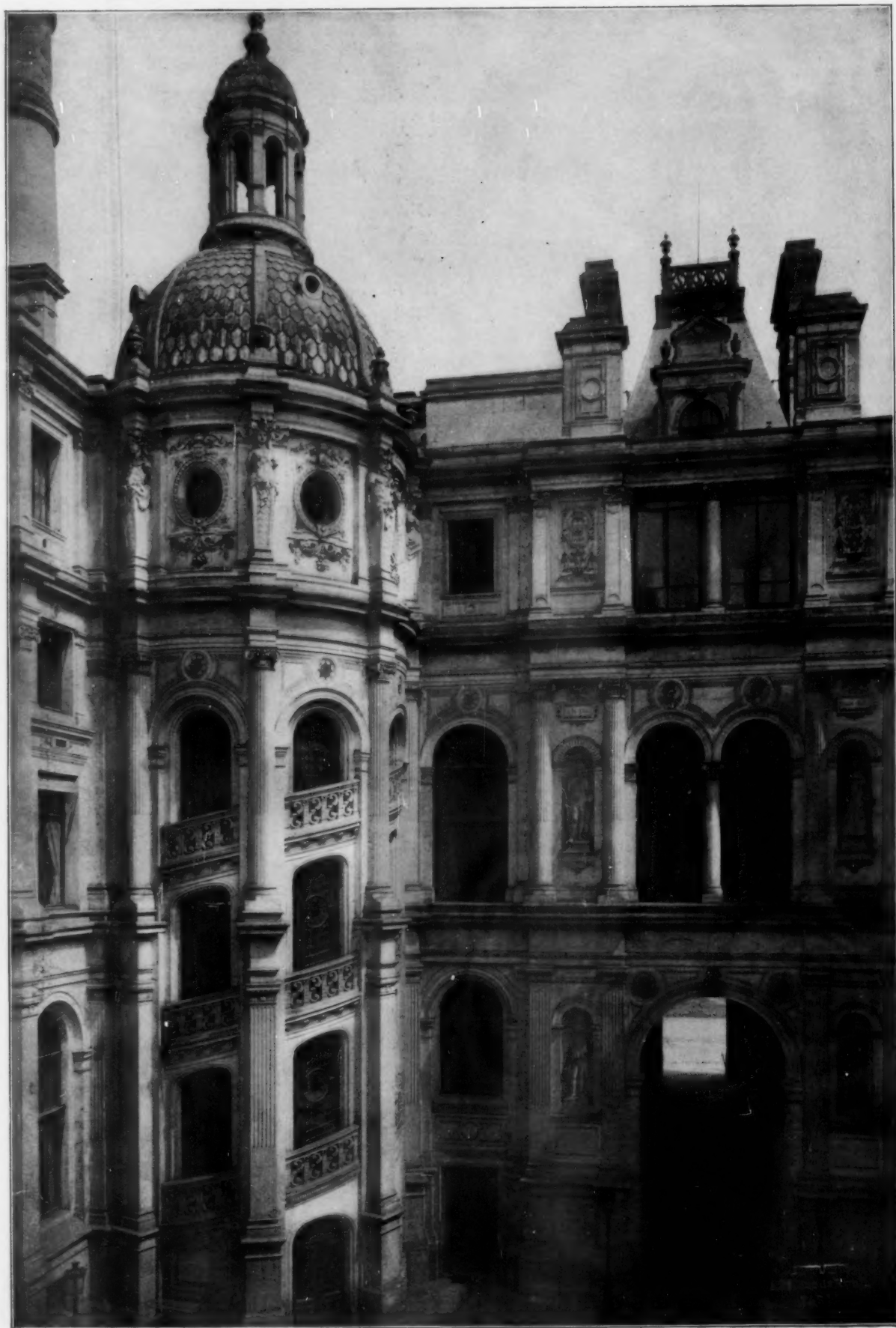
STAIRCASE TOWER: HÔTEL DE VILLE, PARIS, FRANCE.
