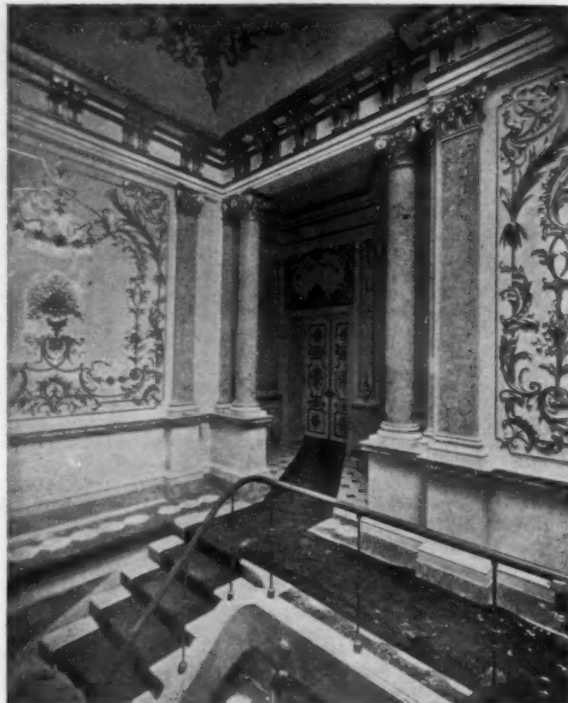
Fig. 80. Staircase Landing, Schloss Herrenchiemsee.
