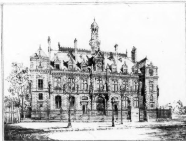
HOTEL DE VILLE DE PANTIN—M. RAULIN, ARCHITECT.
