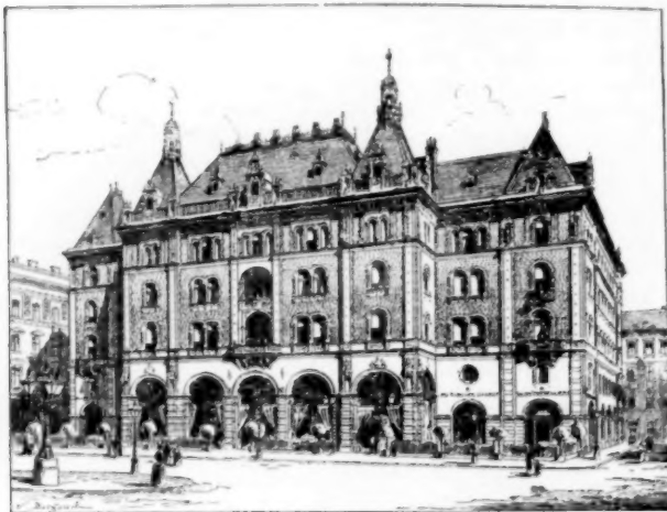
Fig. 40. House in Andrássystrasse, Budapest, Austria.
