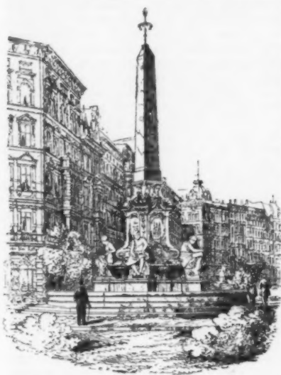
Hasselbach Fountain, Magdeburg. From Deutsche Bauzeitung .
