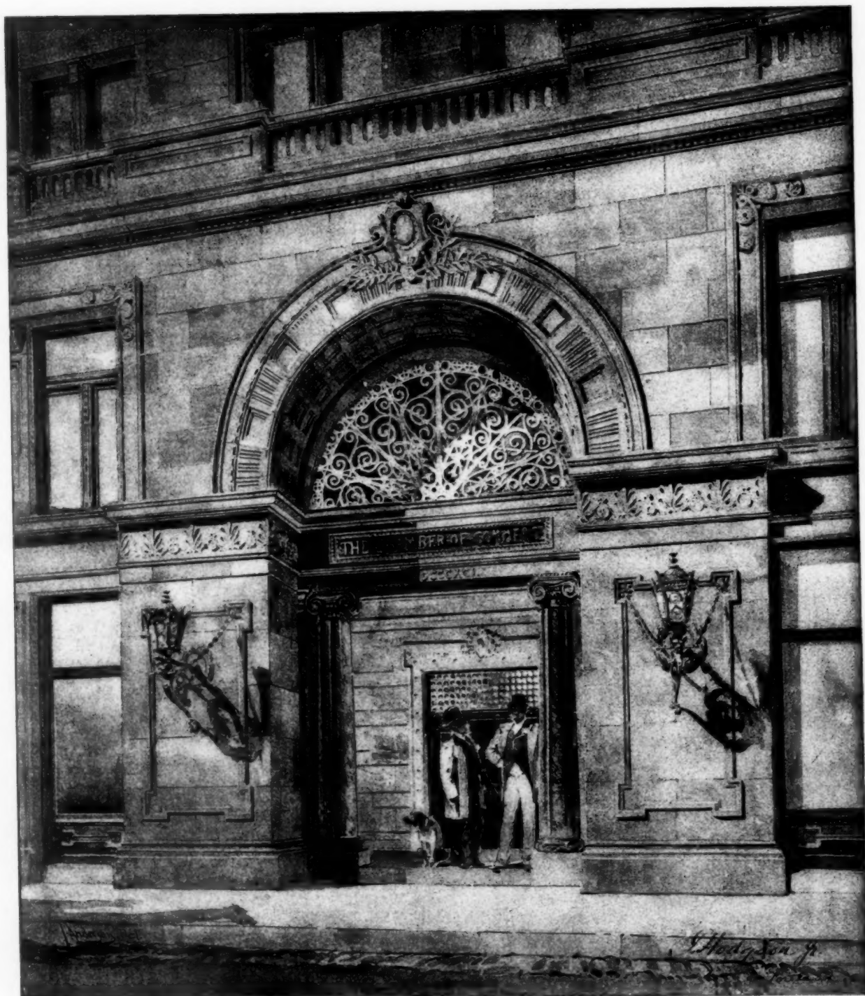
· MAIN · ENTRANCE · TO · THE · CHAMBER · OF · COMMERCE, · PORTLAND · OREGON · · I · HODGSON · JR. · ARCH'T.
