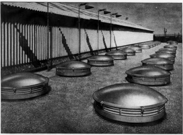
DOME ROOFLIGHT VENTILATORS
