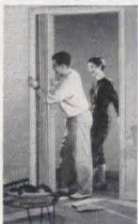
Fit jamb post over clips
