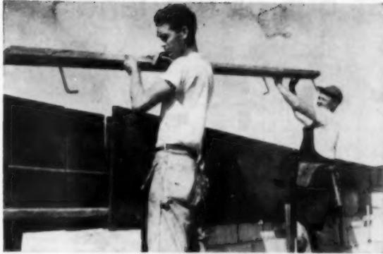
**TOP PLATE IS POSITIONED BEFORE POURING**
