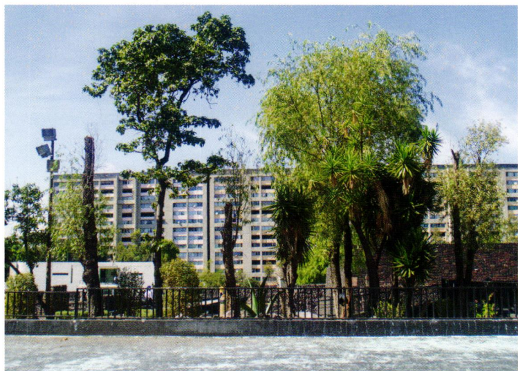
Looking back at Conjunto Urbano Nonoalco Tlatelolco from the Plaza de las Tres Culturas.
