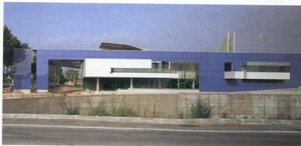
Les pointes du triangle sont ouvertes. Ici, l'accès.
