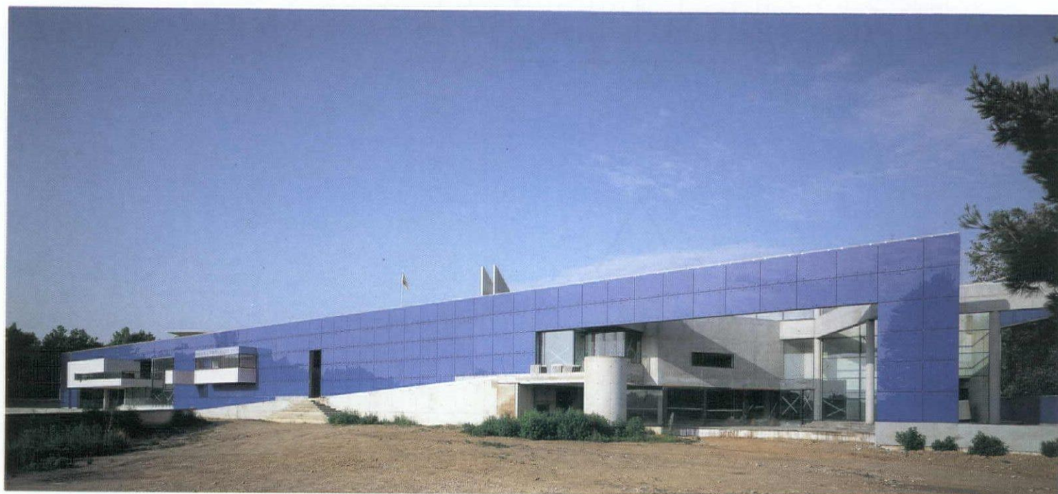
La rampe le long de l'aile culturelle mène à l'auditorium.
