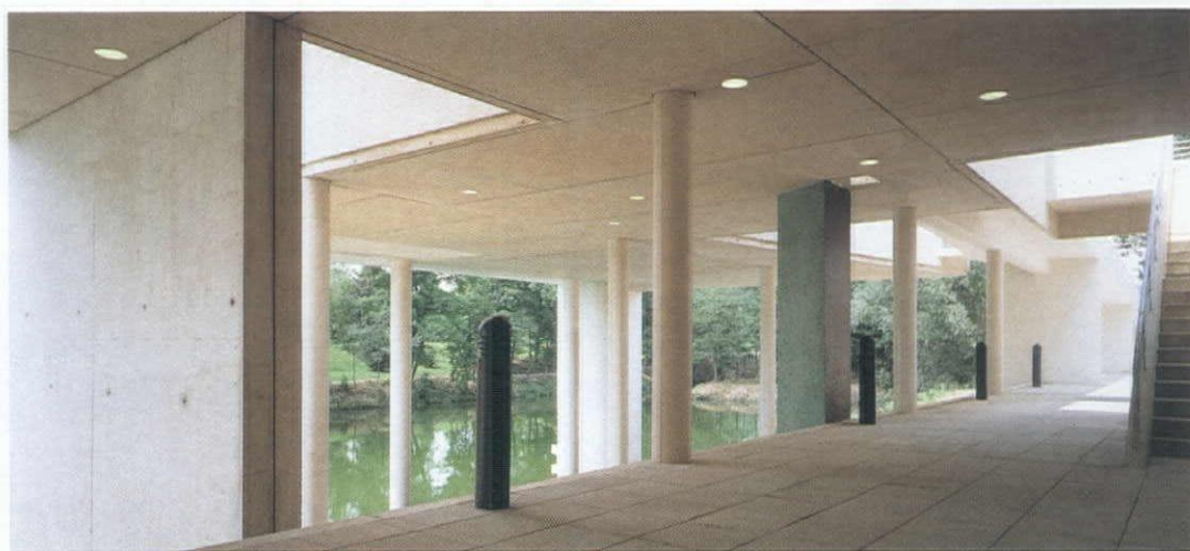
La promenade du bord de l'eau est maintenue sous le bâtiment. Les pilotis découpent des vues sur le paysage.
