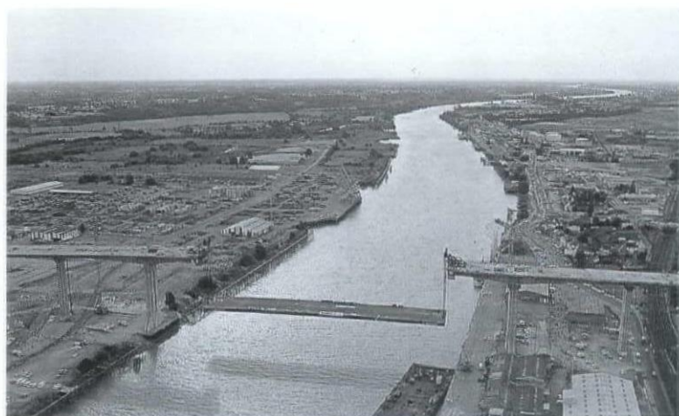
Hissage de la travée centrale du pont en août 1990
