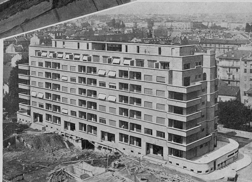
GROUPE D'IMMEUBLES CONSTRUITS A L'AIDE DE LA POMPE A BÉTON
