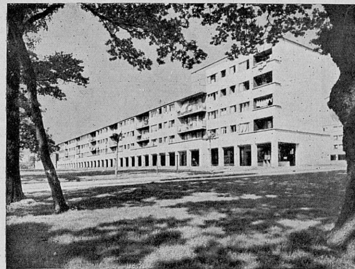
Cité à Genève, architecte: Braillard (Linoléum)
