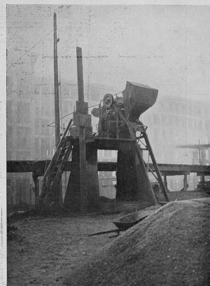
BÉTONNIÈRE RICHIER ALIMENTANT PLUSIEURS CHANTIERS PENDANT LA CONSTRUCTION DU NOUVEL HÔPITAL BEAUJON
