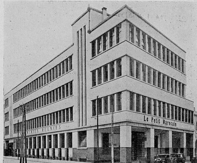
Hôtel du « Petit Marocain », architecte: Seliner (Chantiers)
