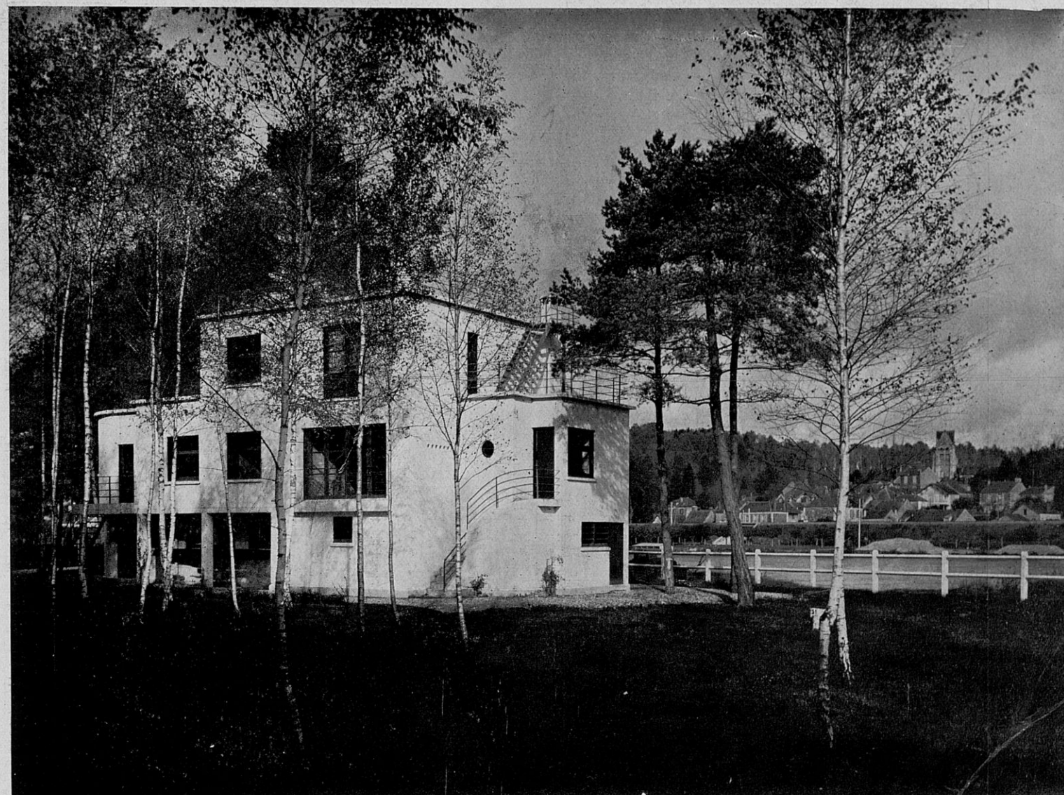
VILLA EN BORDURE DE LA SEINE A FONTAINE-LE-PORT. ARCHITECTES : PAUL FURIET ET A. FURIET
