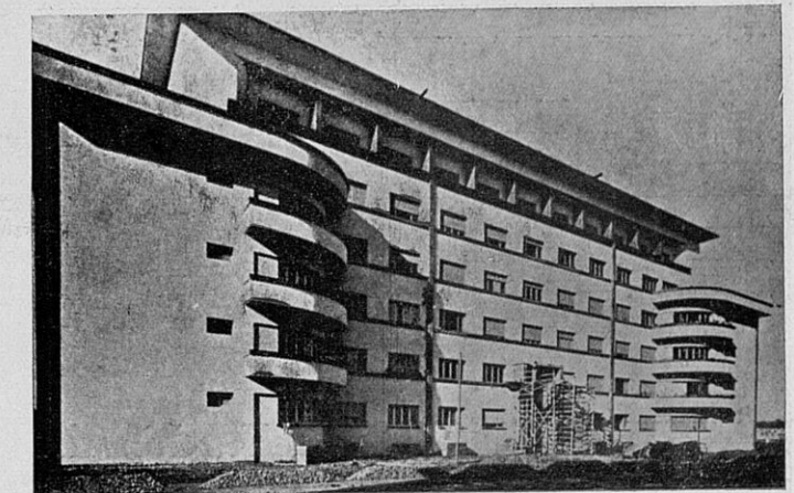
Habitations à bon marché à Bologne (Italie) Architecte: G. Vaccaro (Domus, Septembre)
