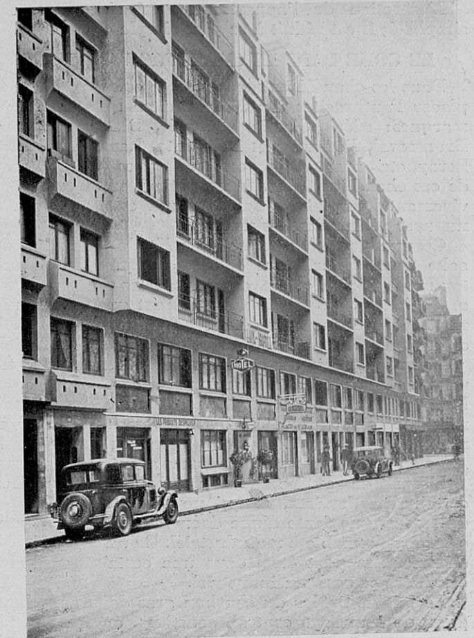
Immeuble avenue Corbera chauffé au Coke de Gaz. (M. Lambla de Sarria, Architecte)
