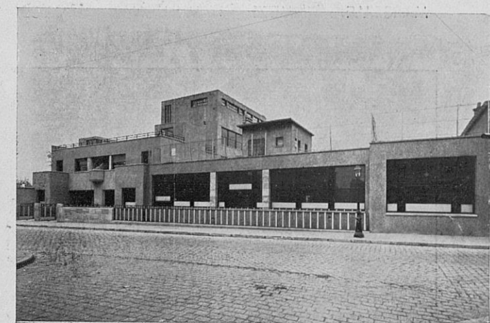
ÉCOLE DE BOULOGNE. - ARCHITECTES : M rs CAUWET ET OGÉ
