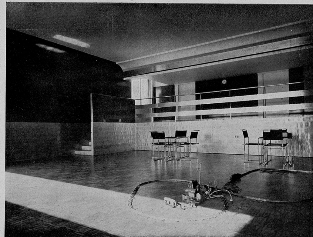
Salle de jeux. Soubassement en aluminium strié, murs en toile cirée écarlate, sol parquet Noël, balustrade aluminium, éclairage indirect.
