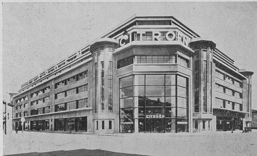
S. A. CITROËN - LYON, ARCH. RAVAZÉ — CHAUFFAGE RÉALISÉ PAR SULZER
