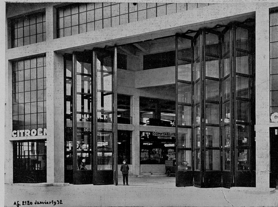
STATION-SERVICE CITROËN A LYON ENTRÉE DU HALL PUBLIC Portes accordéons système B. D. R. réalisées par les Etabl. Baudet, Donon et Roussel de Paris
