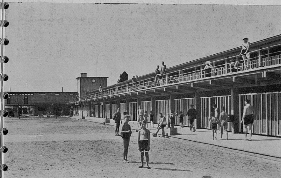
CABINES ET VESTIAIRES. BÉTON, BRIQUES ET BOIS
