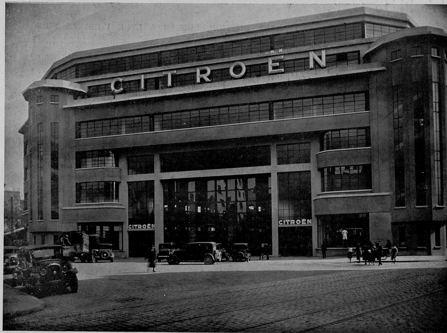
FAÇADE AVENUE FÉLIX FAURE ET ENTRÉE DU HALL PUBLIC
