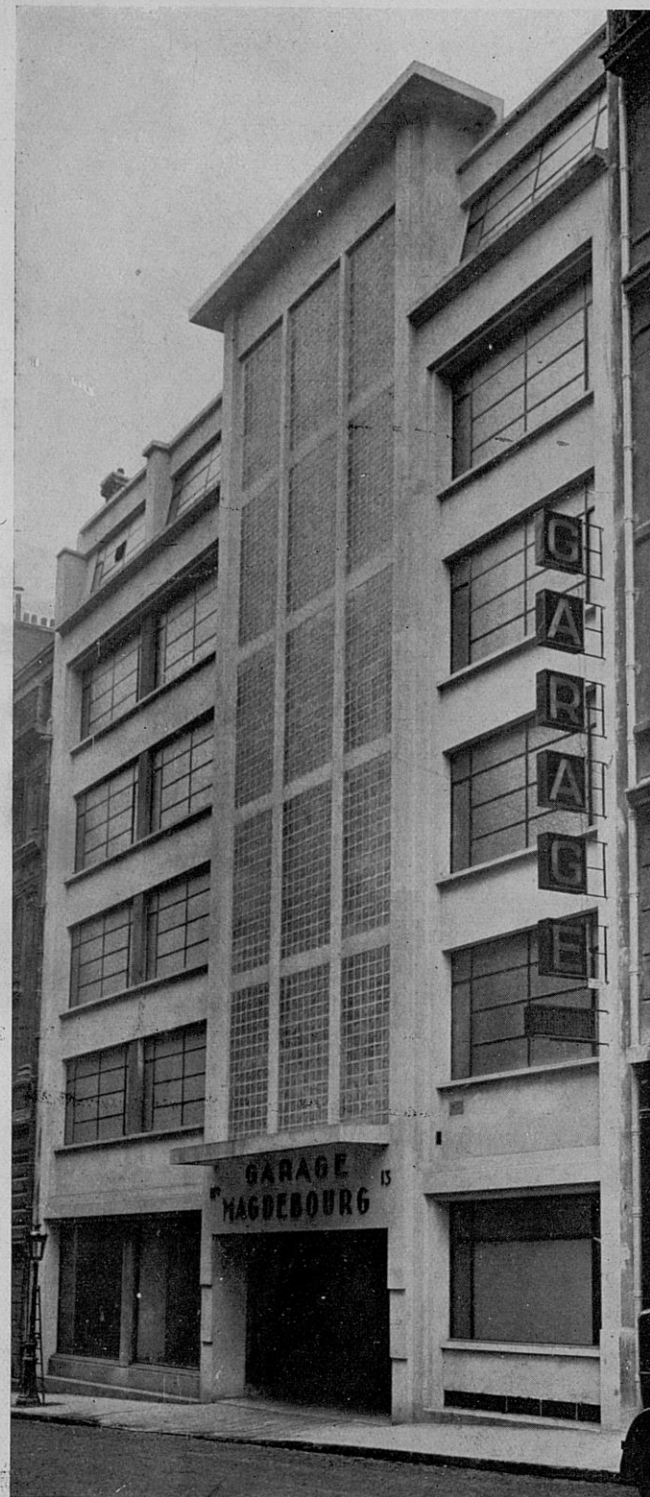
GARAGE MAGDEBOURG A PARIS. C. DE CHESSIN, ARCHITECTE
