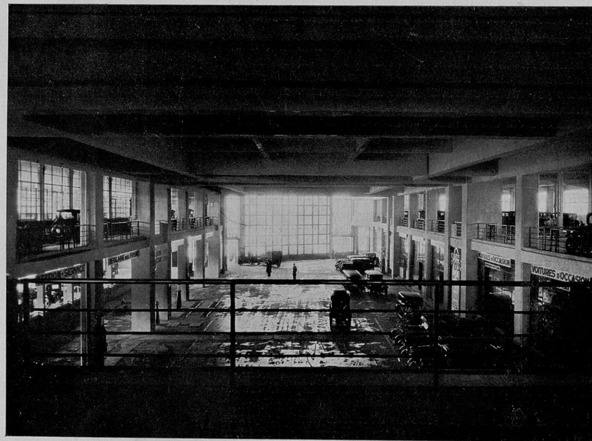
VUE DU HALL PUBLIC: LES POUTRES DE CE HALL ONT DANS LE SENS TRANSVERSAL UNE PORTÉE DE 20 MÈTRES
