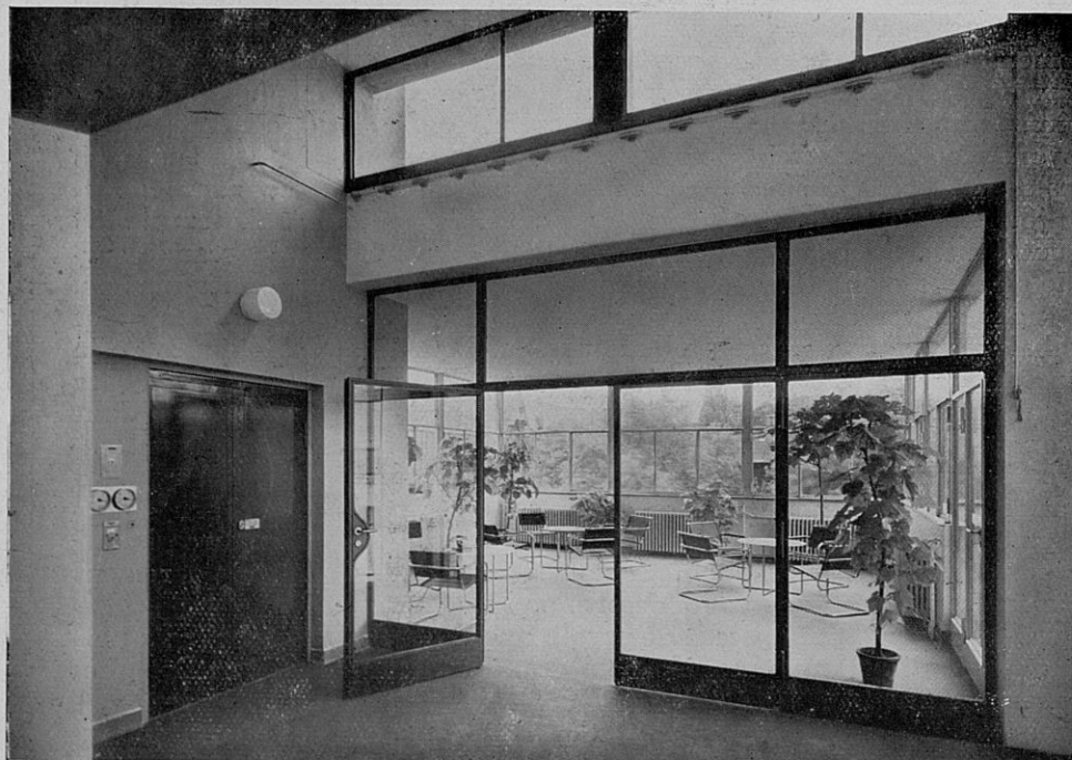
DÉTAIL DE L'ENTRÉE
