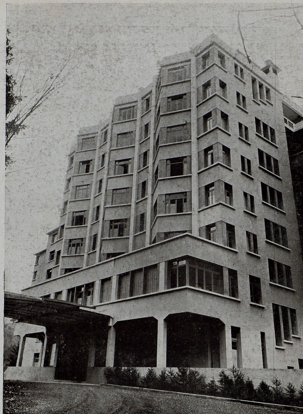
SANATORIUM A SANCELLEMOZ ARCHITECTE: P. L. DUBUISSON
