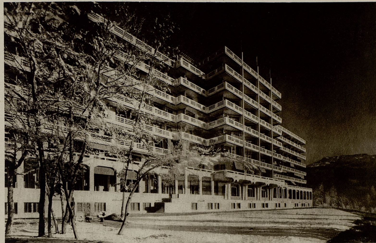
SANATORIUM A SANCELLEMOZ. ARCHITECTE : P L DUBUISSON
