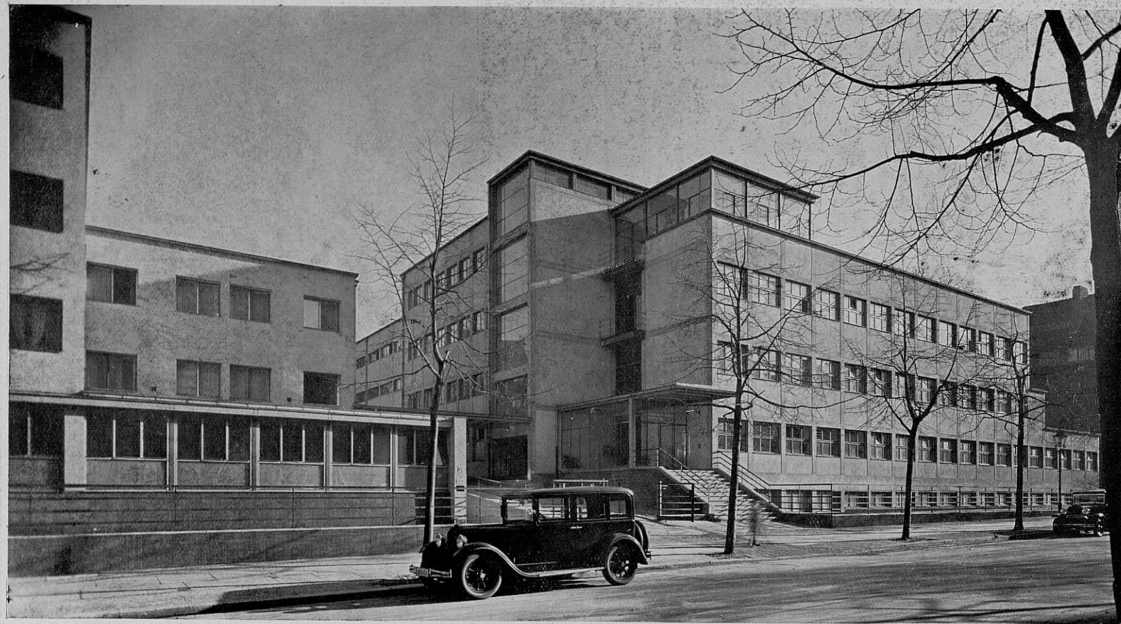
F A Ç A D E S U R R U E REMARQUER L'OSSATURE EN B. A. APPARENTE EN FAÇADE
