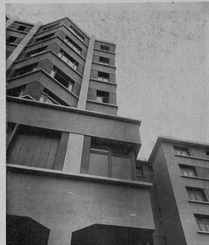
COUR CENTRALE - FAÇADE NORD
