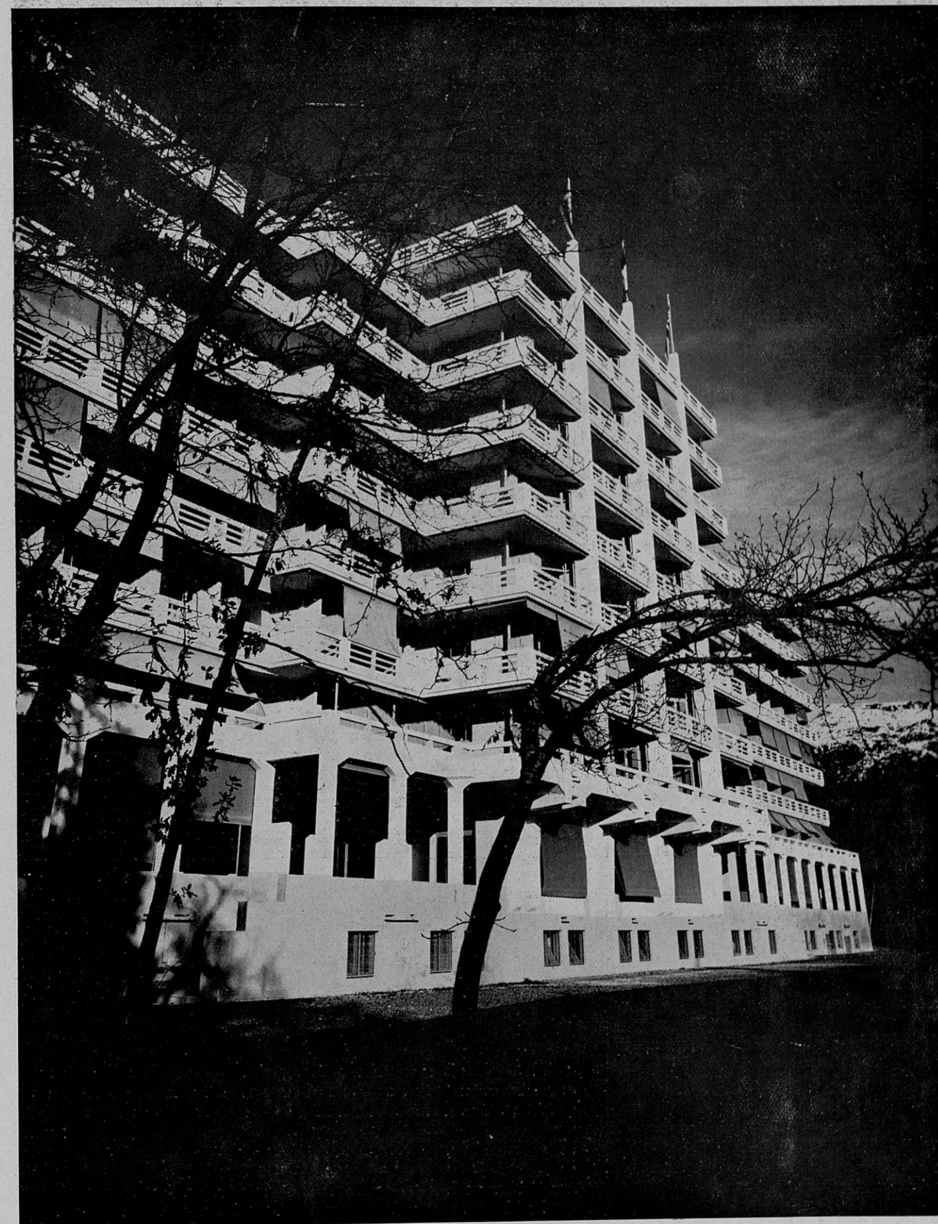
SANATORIUM A SANCELLEMOZ. ARCHITECTE: P. L. DUBUISSON
