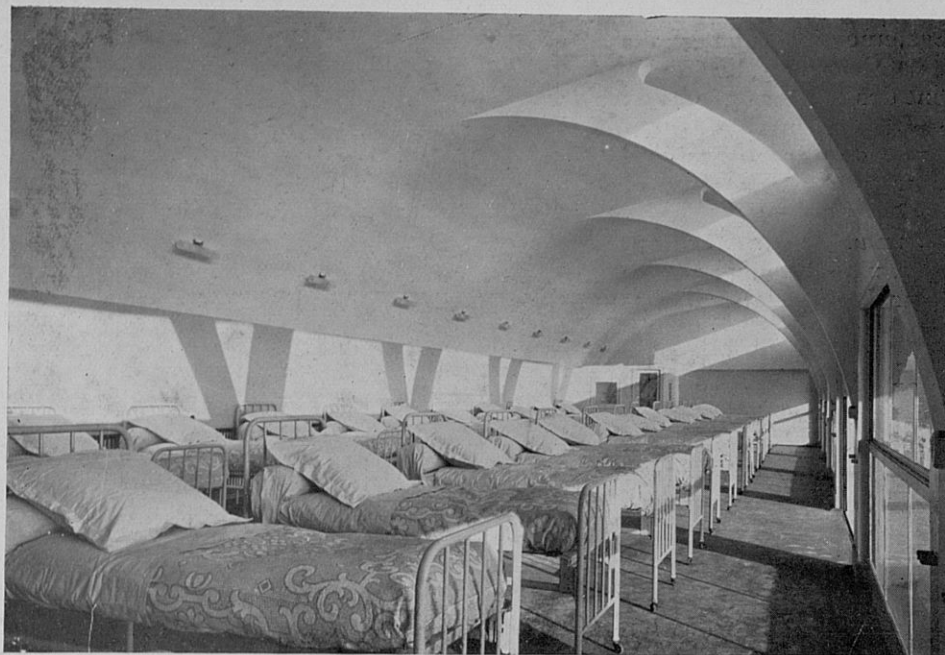
SANATORIUM DU « ROC DES FIZ » A PASSY (HAUTE-SAVOIE). VUE INTÉRIEURE DU DORTOIR D'UN PAVILLON DE CURE
