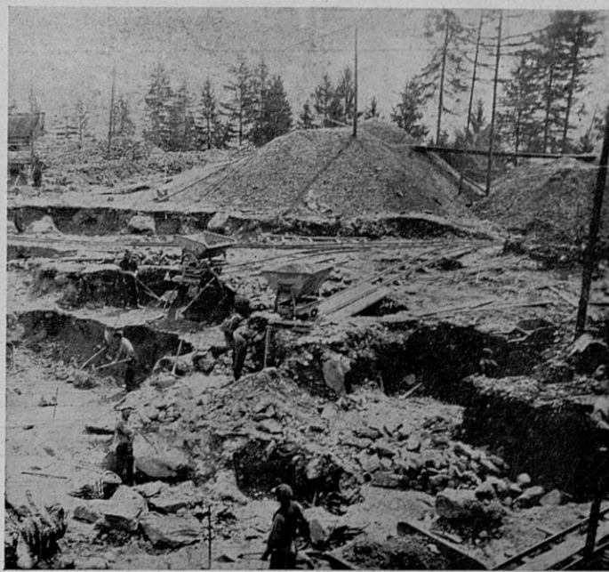
TRAVAUX D'ÉTABLISSEMENT DE LA GRANDE TERRASSE PAR LES ÉTABL. PAUL PIKETTY ET CIE QUI ONT EXÉCUTÉ L'ENTREPRISE GÉNÉRALE
