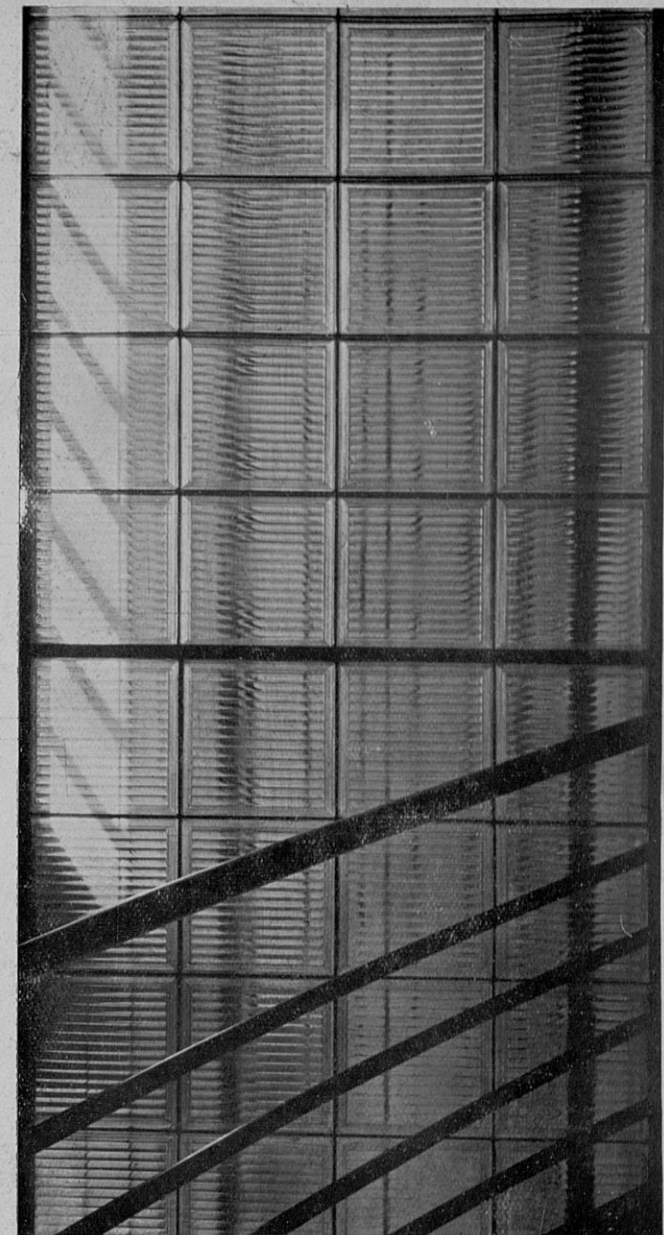
LA VERRIÈRE DE L'ESCALIER EN PRISMES DE VERRE RELIÉS ÉLEC- TROLYTIQUEMENT PAR DU CUIVRE
