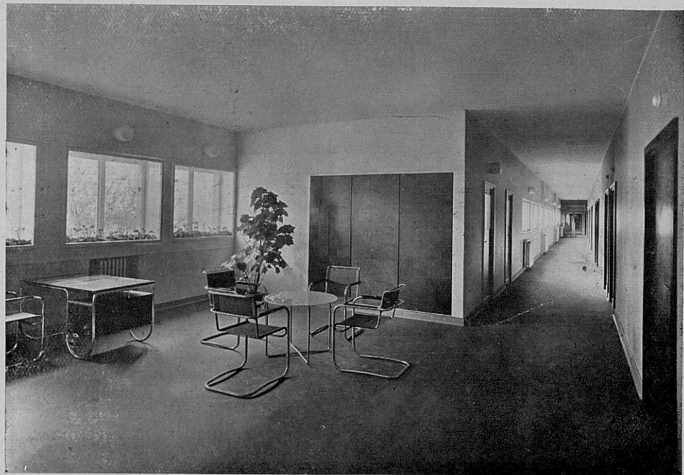
DÉTAIL D'UNE GALERIE
