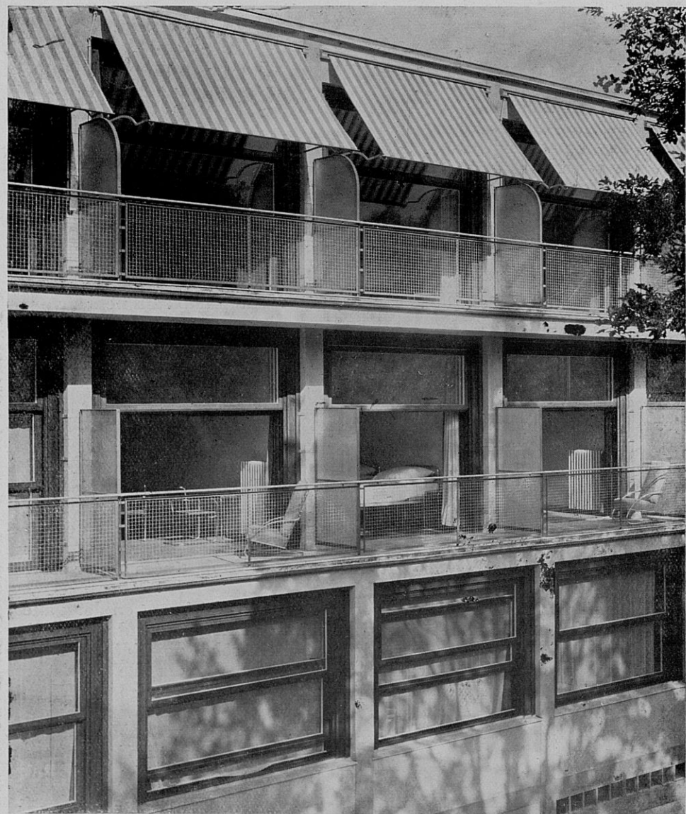
F A Ç A D E S U R R U E REMARQUER L'OSSATURE EN B. A. APPARENTE EN FAÇADE
