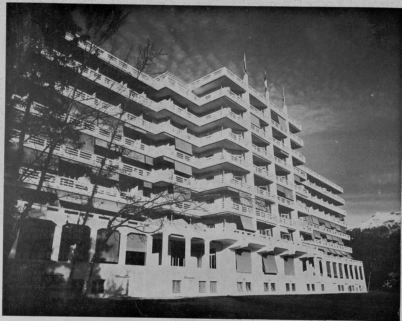
SANATORIUM A SANCELLEMOZ. ARCHITECTE: P. L. DUBUISSON
