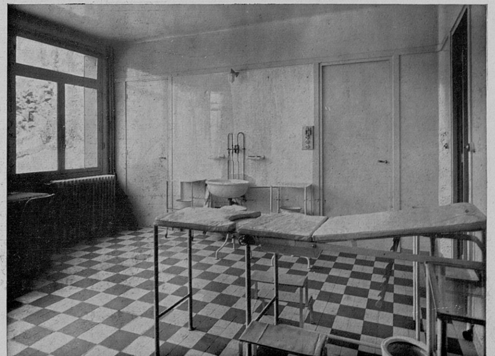
SALLE D'EXAMEN ET D'INSUFFLATION Tout le matériel des tables d'opération et stérilisation a été fourni par les Etablissements DUFFAUD et Cie. 11, rue Dupuytren, Paris.
